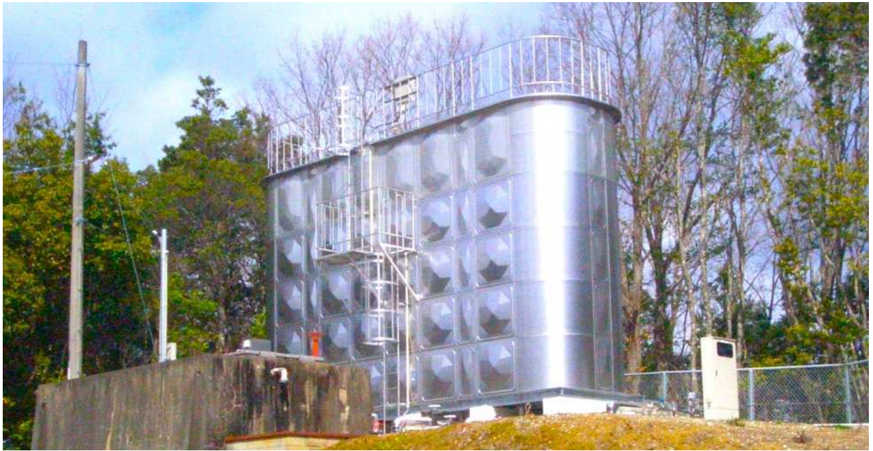
大二谷配水池
