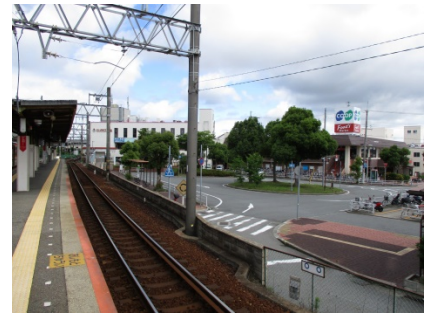
志染駅北側駅前広場
