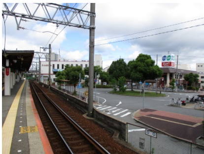
志染駅北側駅前広場
