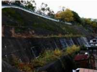
⑤本丸跡北西斜面。モルタル/コンクリート仕上げとなっている。
