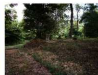
⑫主部檜台。檜台の盛土が流出している。
