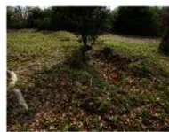
④高木大山土塁A。手前側が土取りのため、一部滅失している。
