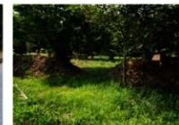
②虎口土塁上の樹木の根場により、遺構が破壊される恐れがある。
