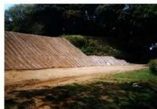
本佐倉城跡の法面保護工事 (酒々井町教育委員会提供)
