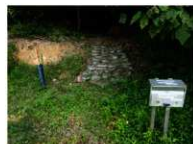
②法界寺側入口の土義階段。非常に滑りやすい。
