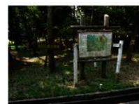
③周辺案内板。老朽化している。
