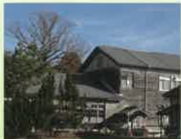
解体直前の旧「新館」
