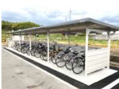
完成した駐輪所
