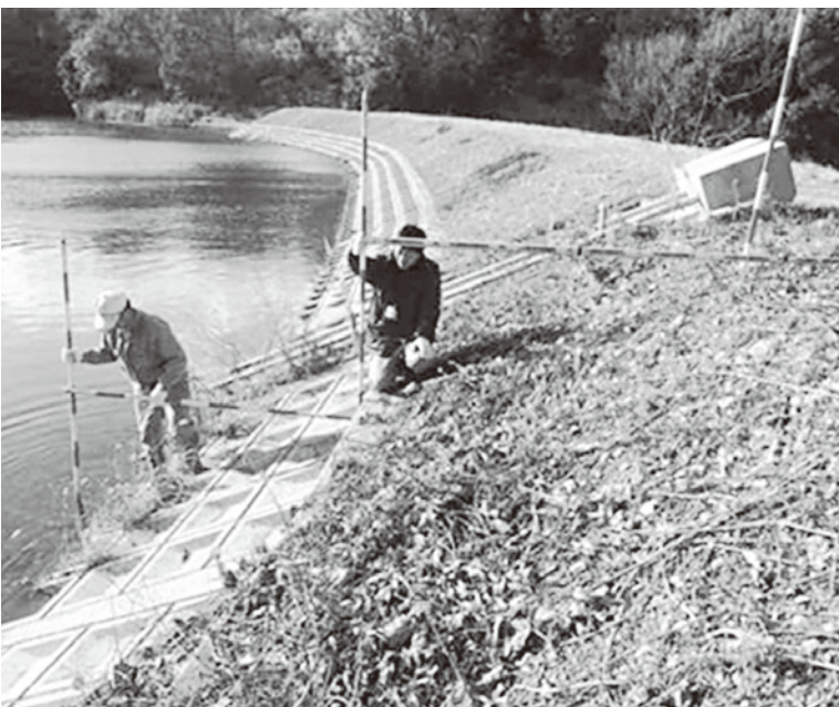
▲市が行うため池の定期点検の様子
