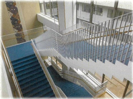
階段ごとに色分けし、どこにある階段かを分かりやすくしています。
