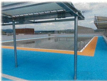
水が汚れにくく、外から見えない屋上設置の大・小プールです。
