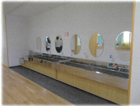
手洗い場は、発達に合わせ、階により高さを変えています。
