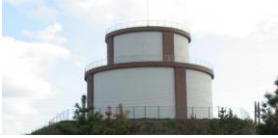
みなぎ台配水池
