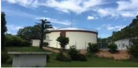
三木山配水池
