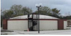
北部低区配水池
