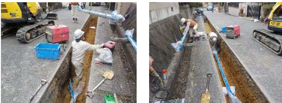
－耐震管への布設替工事の状況－
