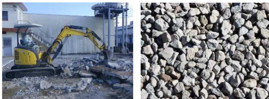
－左：掘削の状況 右：使用している再利用材－
