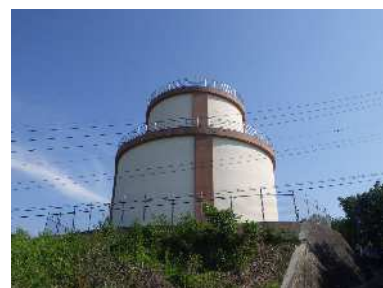
－みなぎ台配水池－
