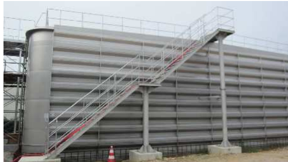
－耐震化工事が完了した西部浄水場－
