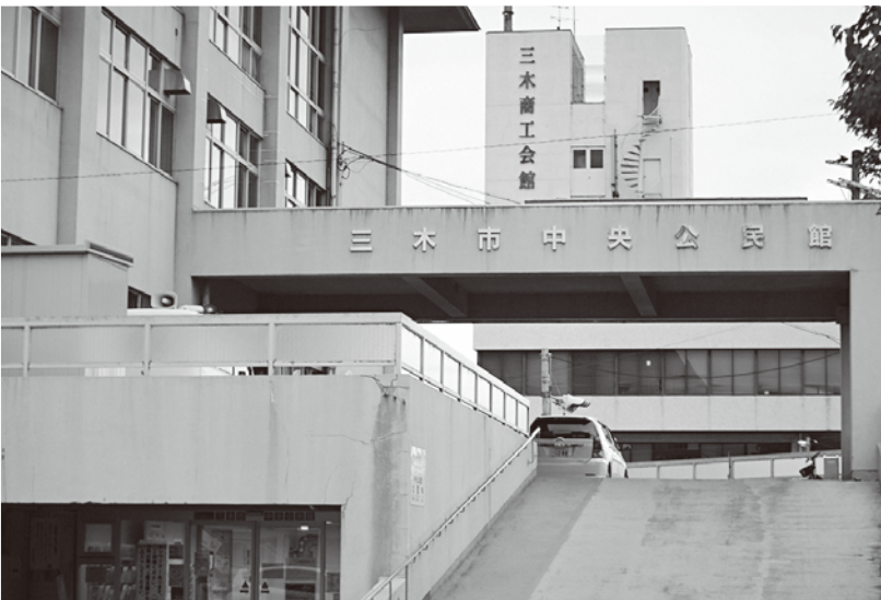
▲複合施設として整備予定の中央公民館と三木商工会館
