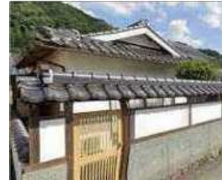
漆喰塗りに見える事例 〔建物：モルタル壁に白色塗装〕 塀：ケイカル板に白色塗装
