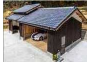
（事例2）樹脂混入繊維補強軽量セメント瓦
