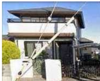
漆喰塗りに見えない事例（※助成対象外） 〔建物：モルタル壁に白色塗装〕 塀：同上
