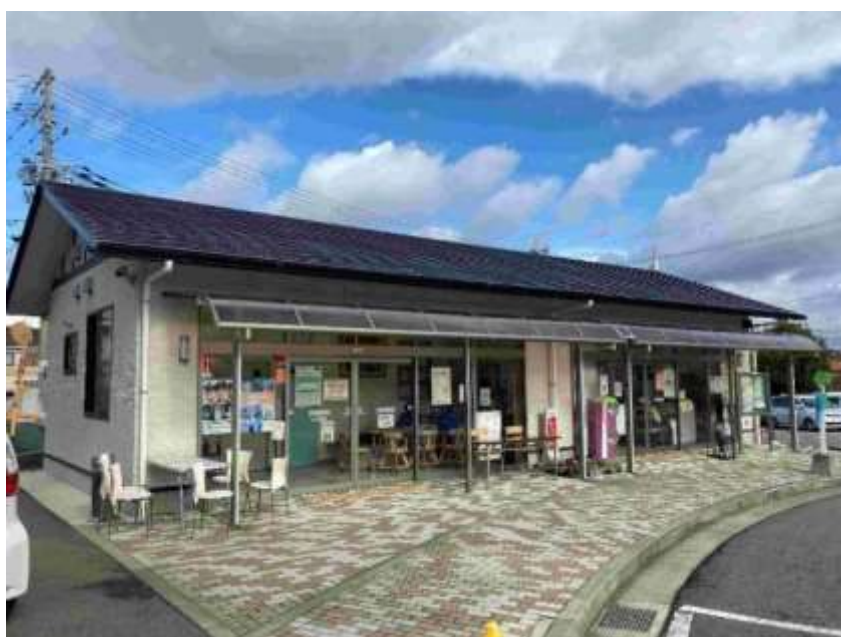
図 4.13-2 自由が丘中公園バス待合施設（わくわくステーション）
