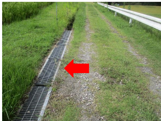
例) グレーチング設置状況 (農道部)
