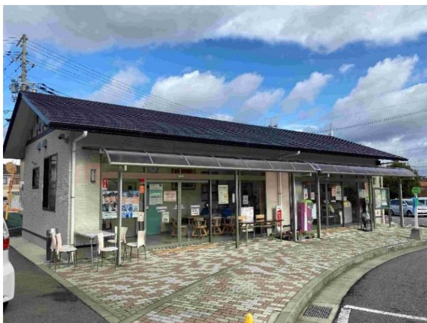
図 3.13-1 自由が丘中公園バス待合施設（わくわくステーション）
