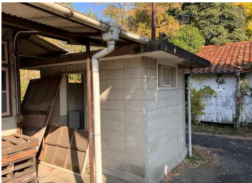
南面・東面（南東から）
