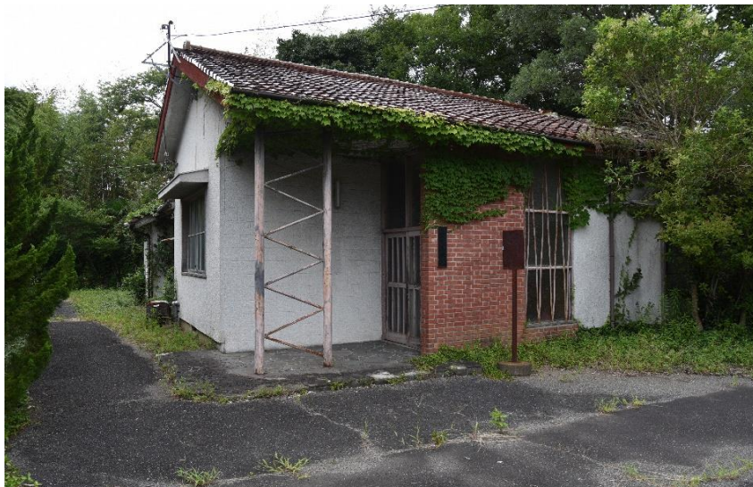
東面・南面（南東から）
