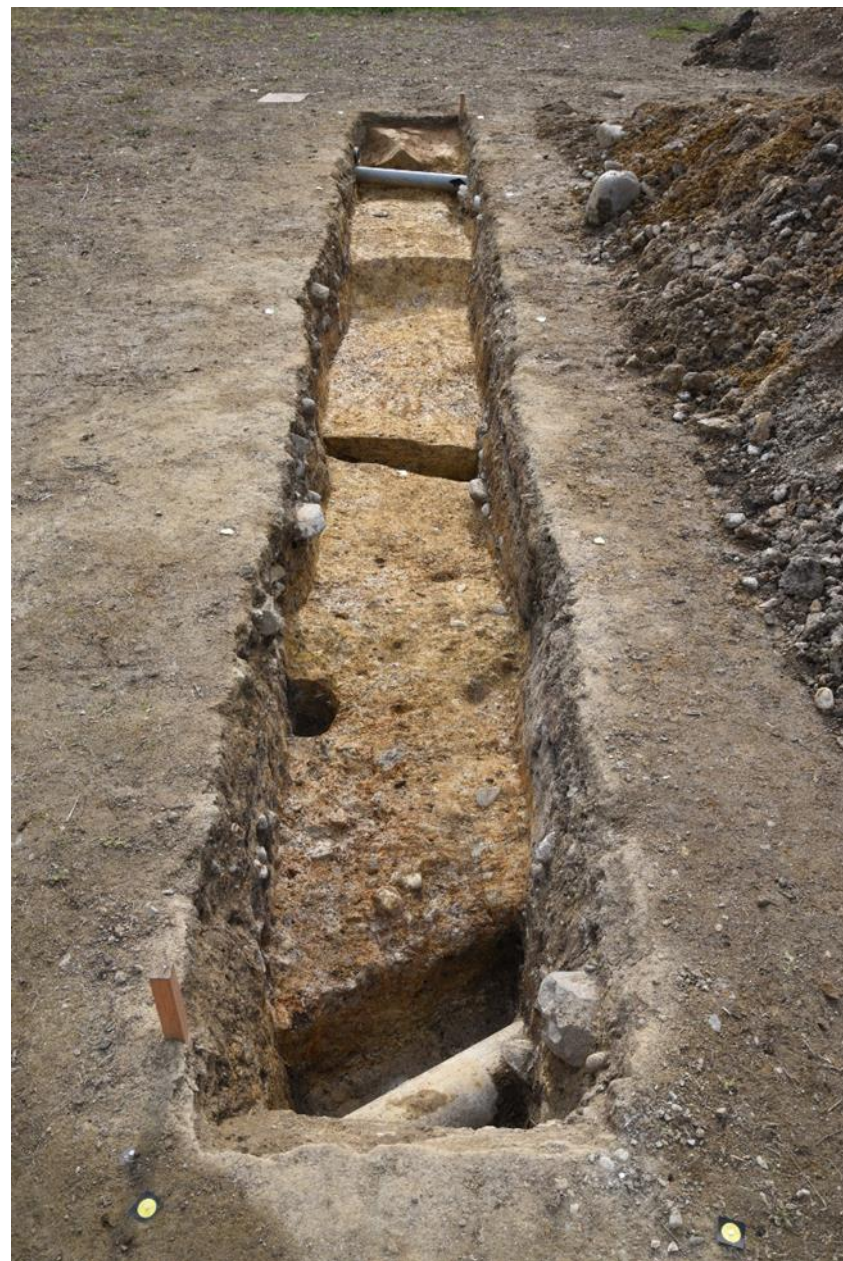
T4 完掘状況(北から)
