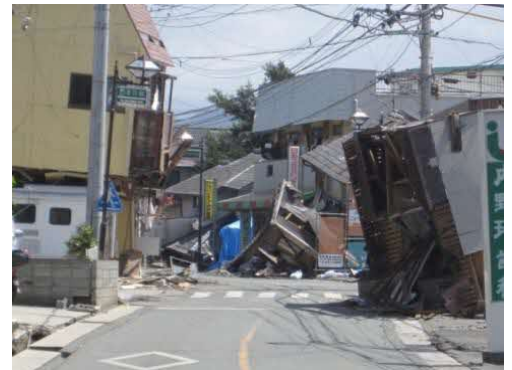
地震で損壊した建物
