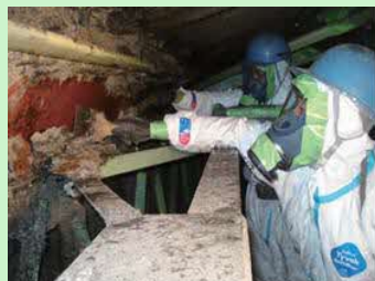
吹付け石綿の除去作業の様子
