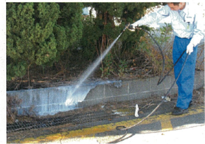
専門業者による液剤の高圧散布
