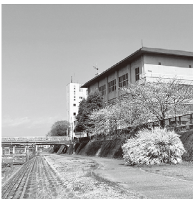
▲複合化予定の中央公民館と三木商工会館
