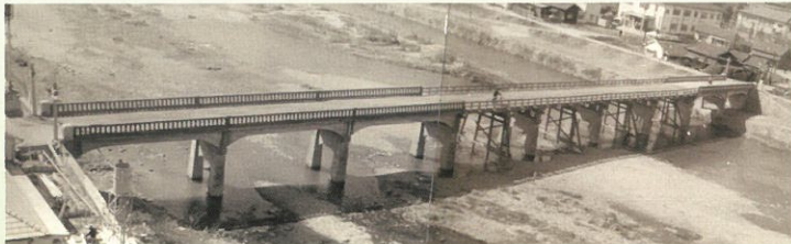
写真 1 昭和 30 年頃の城山橋（川を拡幅したため、北側（写真右側）にさらにコンクリート造の橋が付属している）
