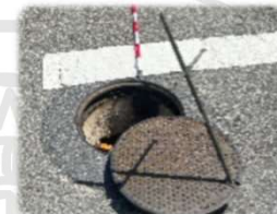
下水道管の点検・修繕
