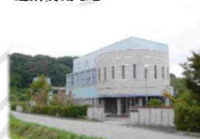
汚水処理場の維持管理
