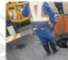
下水道管路の清掃
