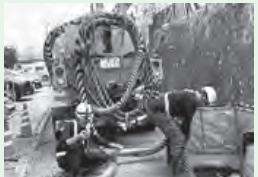
▲詰まりの除去作業
