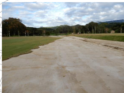
堀平面表示例(九戸城跡) (コンクリート舗装)
