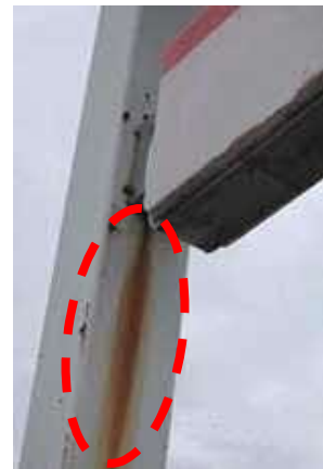
看板本体からポールや壁面への汚ダレは取付部分（ブラケット）の腐食サイン
