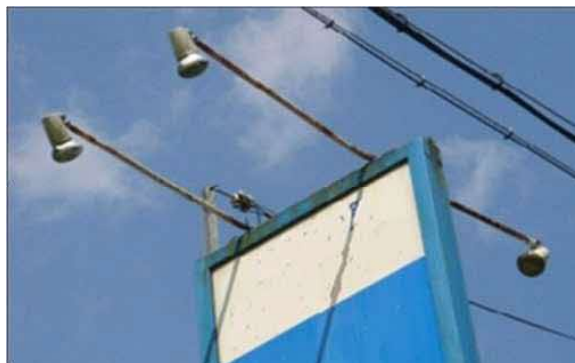
外照式照明器具アーム の変形・さび
