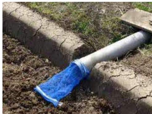
取水口への網の設置
