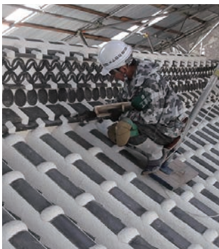
▲白漆喰が壁や屋根目地を彩る姫路城。「白鷺城」と称される美しさ
