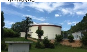
三木山配水池
