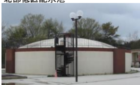
北部低区配水池
