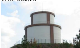
みなぎ台配水池
