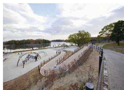
〔②敷地内スロープ〕
