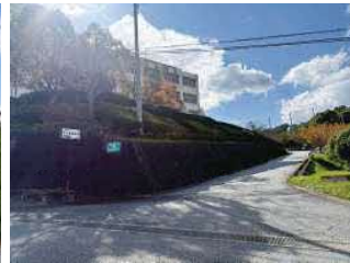
②-1 敷地内通路
